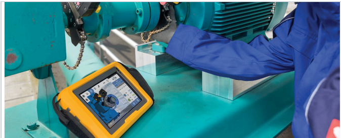
모터-펌프 커플링에 레이저 · 센서 설치
