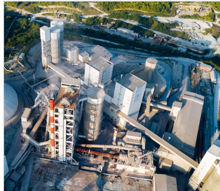
공장 설비 · 저장 탱크
